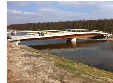
Abbildung zeigt Holz- Beton- Verbundbrücke in Wirschoten - NL
