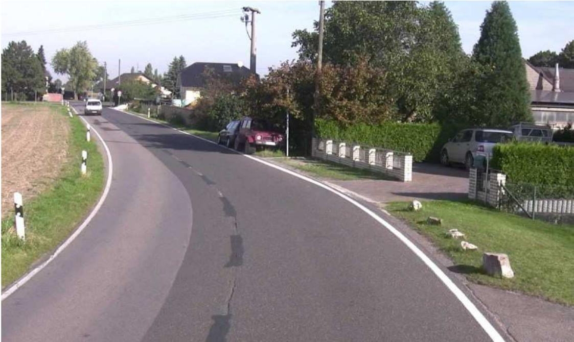
Der Straßenoberbau bestand im Wesentlichen aus einer Schottereinstreudecke, die im Rahmen von Instandsetzungen einen bituminösen Deckenbelag erhalten hatte. Zudem war der Oberbau nicht frostsicher und tragfähig gegründet, was im Winter immer wieder zu größeren Schäden führte.
