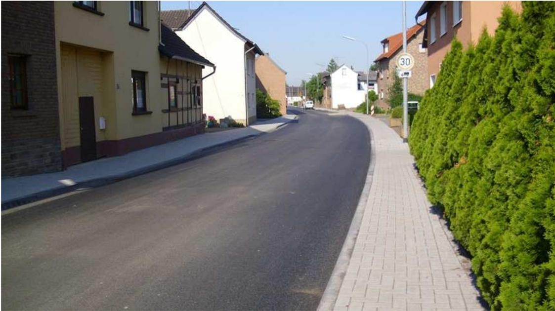
6 m breite Fahrbahn mit beidseitigem Gehweg
