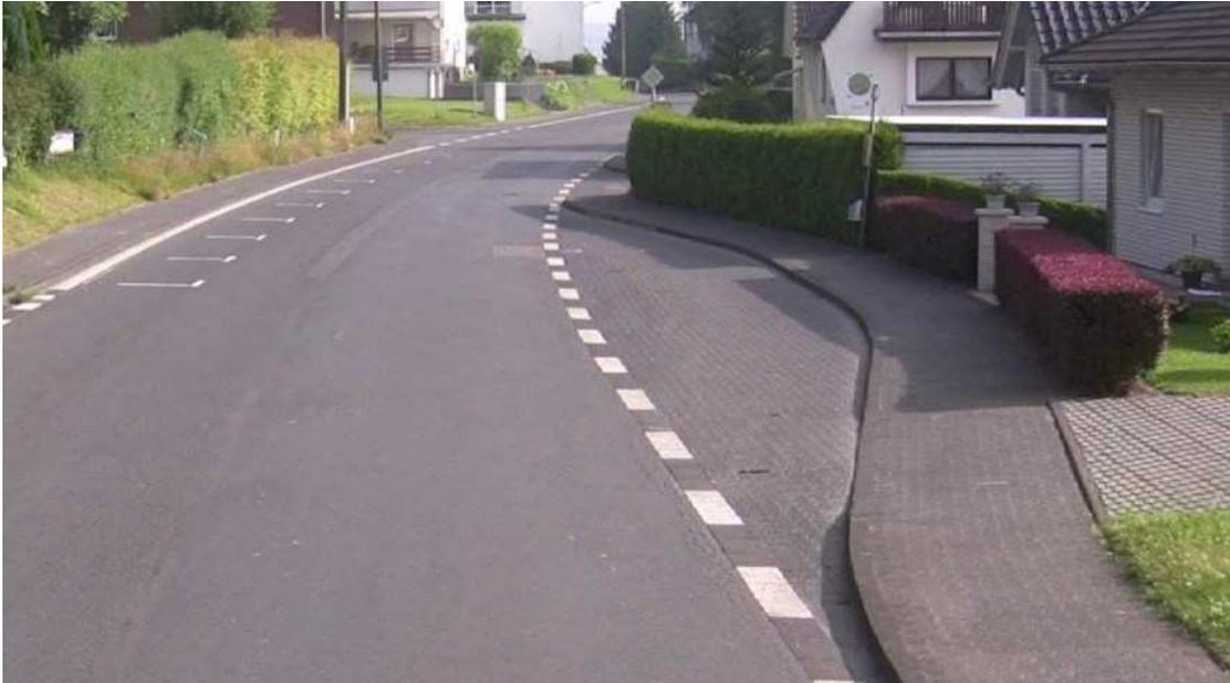
Die Maßnahme K 27 Eitorf-Irlenborn, Los 1.8, wurde zwischen dem 29.04.2014 und dem 16.05.2014 durchgeführt. Zwischen Km 4+530 und Km 4+580 wurde der Pflasterbelag einer Busbucht ausgebaut und durch eine Schwarzdecke ersetzt. Der Pflasterbelag war stark zerfahren und größtenteils hatten sich die Steine gelockert.
