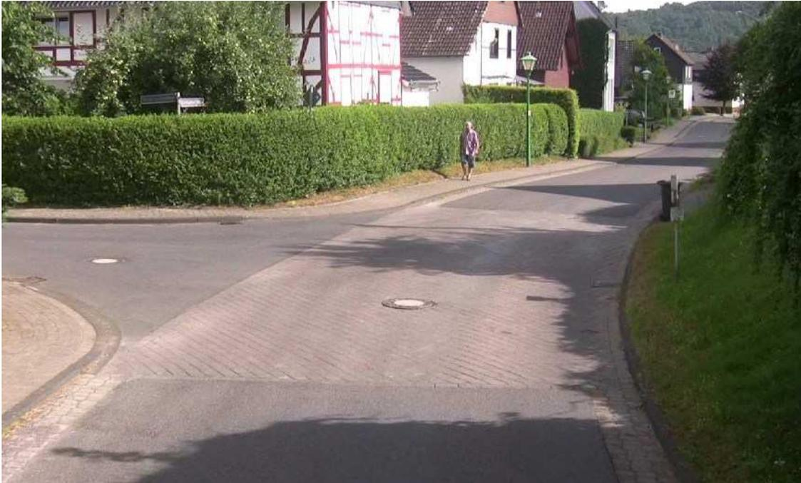
Die Maßnahme K 18 Eitorf-Bitze, Los 1.6, wurde zwischen dem 29.04.2014 und dem 16.05.2014 durchgeführt. Von Km 5+953 bis Km 5+980 wurde der vorhandene Pflasterbelag entfernt und durch eine Schwarzdecke ersetzt. Der Pflasterbelag war stark zerfahren und größtenteils hatten sich die Steine gelockert.
