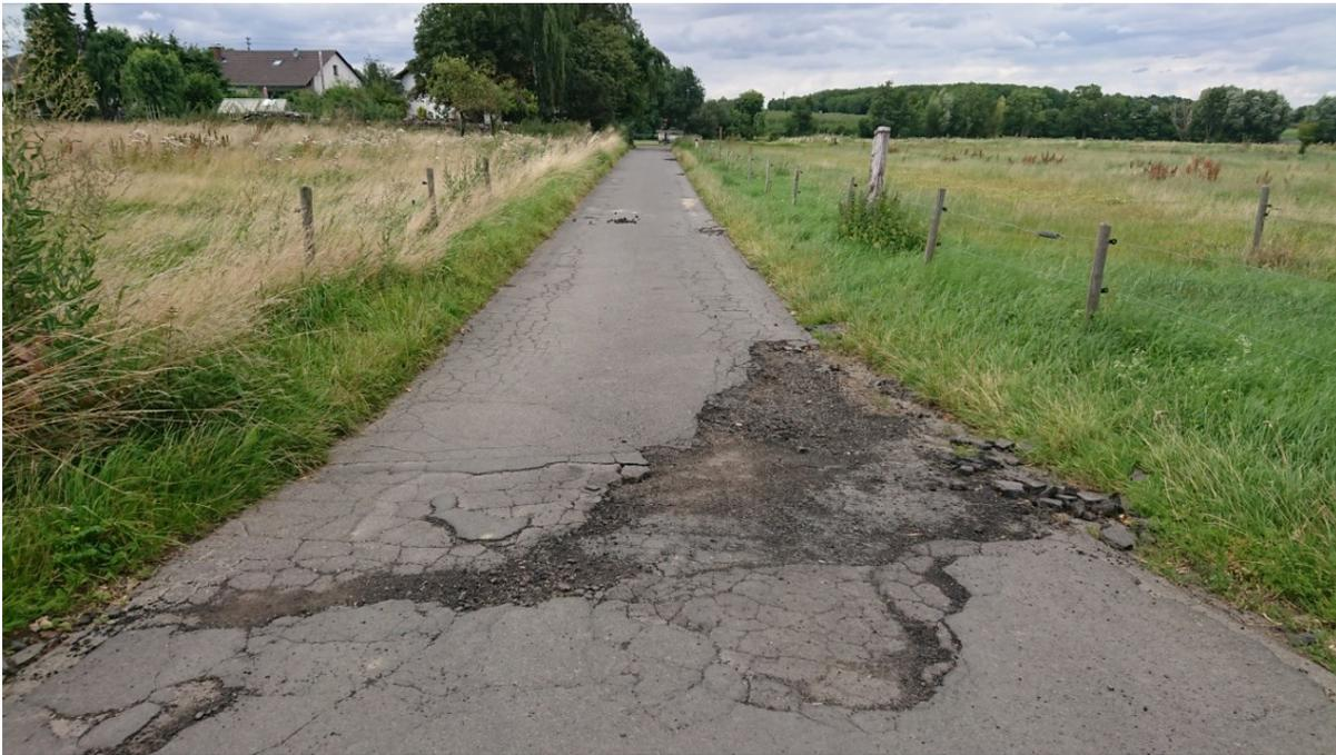
Foto 2: Flächenhafte Aufbrüche der Asphaltdeckschicht
